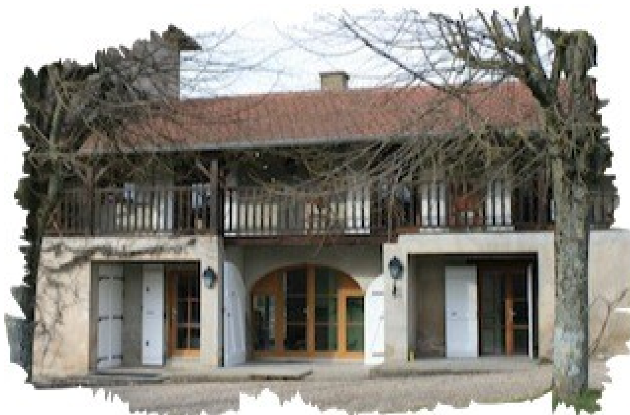
Le gîte coté sud et son entrée
